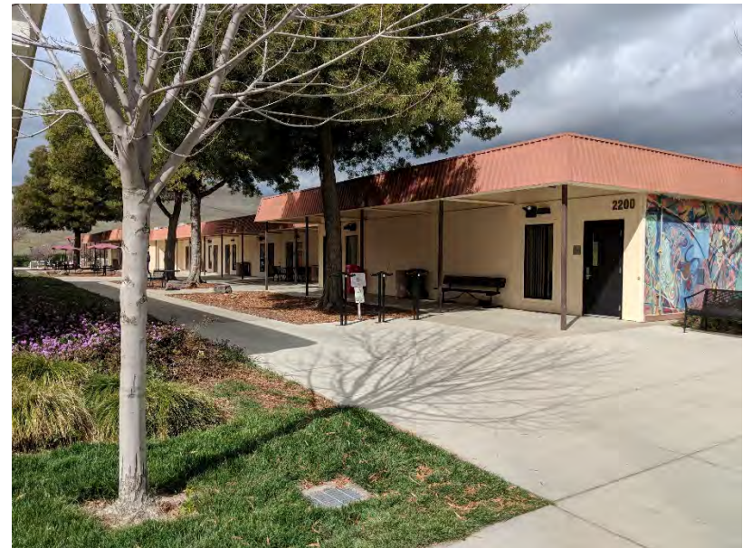
Las Positas Building 2200
